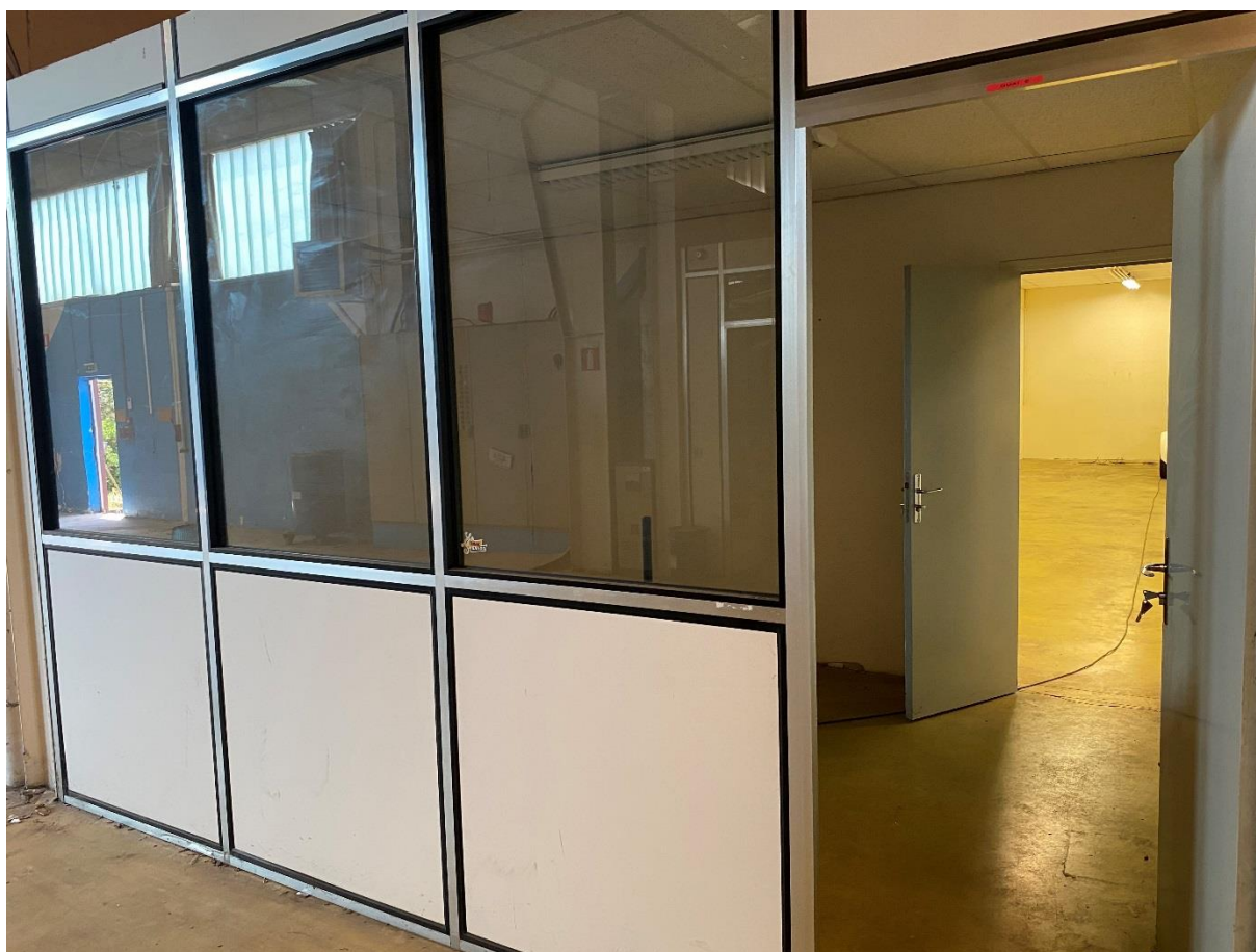
bureau 2 desservant l'accès à l'atelier électricité en zone 2A
