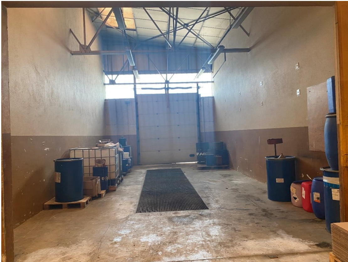
aire de lavage situé en zone 2 A et jouxtant l'atelier peinture
