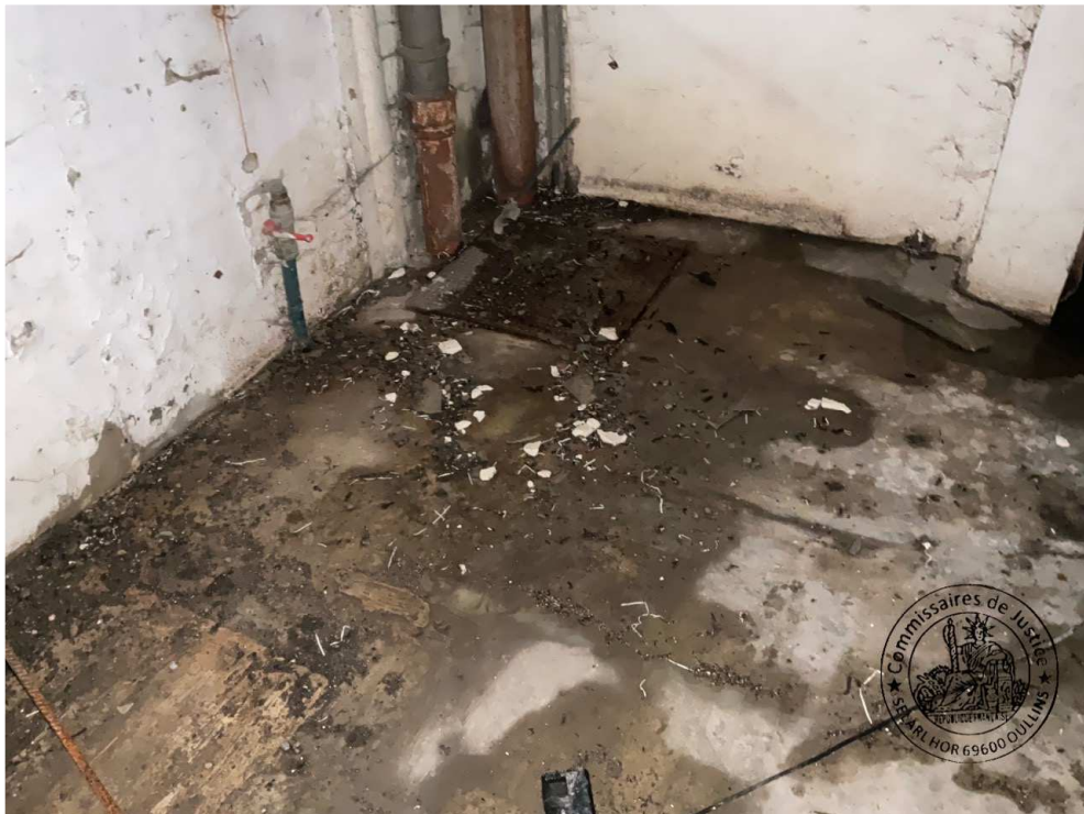
Présence d'un caisson en dessous d'une lucarne.
