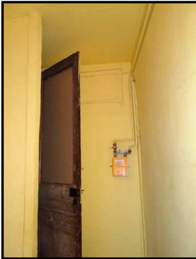
*Le mur donnant sur la cage d'escalier est recouvert de peinture fissurée en partie basse, surmontée de baies fixes dont une vitre est cassée.*
