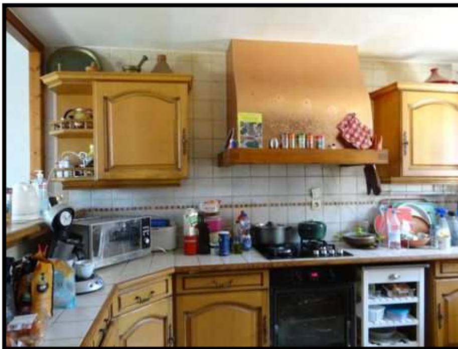
Présence d'une chaudière à gaz.
