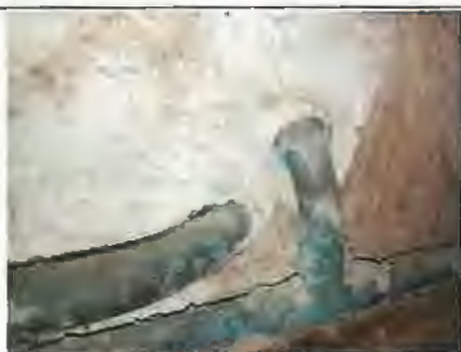
Photo n° conduit oxydé Localisation : Rez de chaussée - Cuisine
