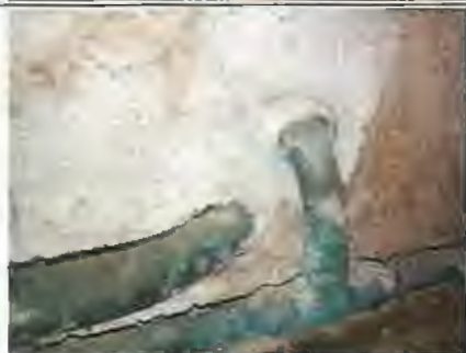
Photo n° PhGaz001 5 : l'espace annulaire de la canalisation gaz à la pénétration dans le logement est obturé. Si oui, il est obturé. (Nota: ce libellé comporte une erreur et sera prochainement corrigé par l'AFNOR pour être remplacé par "l'espace annulaire de la canalisation gaz à la pénétration dans le logement n'est pas obturée.") L'espace annulaire n'est pas obturé; Faire intervenir un installateur gaz qualifié afin de l'obturer correctement
